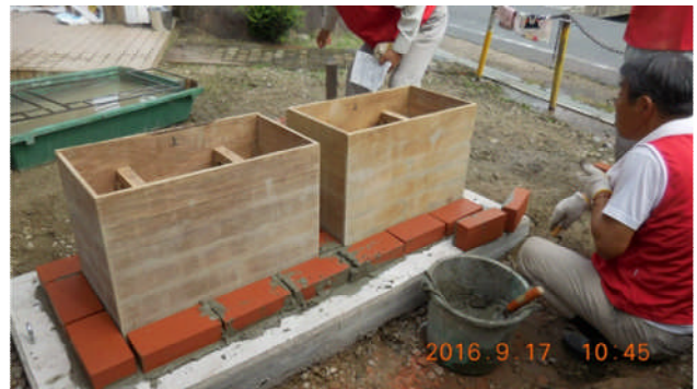
レンガを載せて目地にモルタルを塗りこむ
