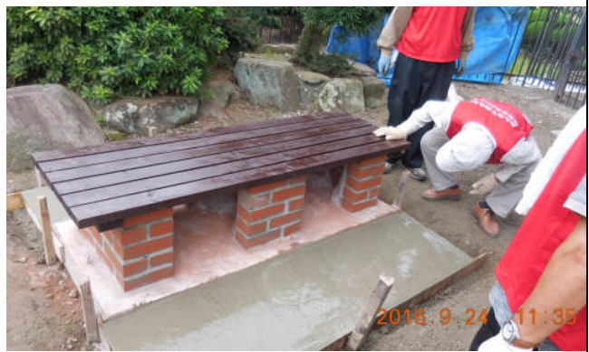
レンガを載せて目地にモルタルを塗りこむ
